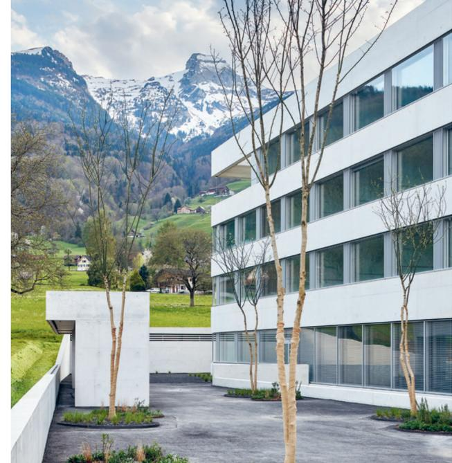
Die Fensterelemente lassen sich «bündig» in die äussere Betonschale einpassen.
