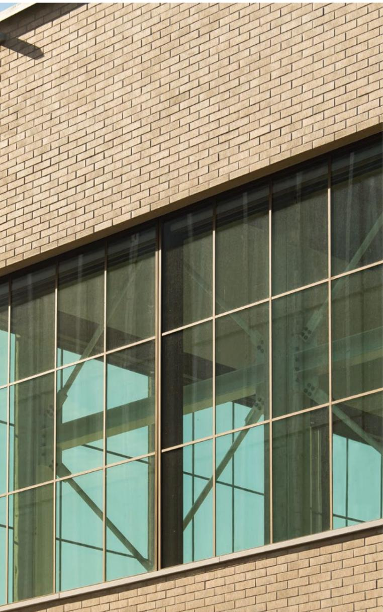
*Aepli-Air-Control-Fassade mit speziell aufgebrachtem 30 mm starkem Aluminium-Element.*
