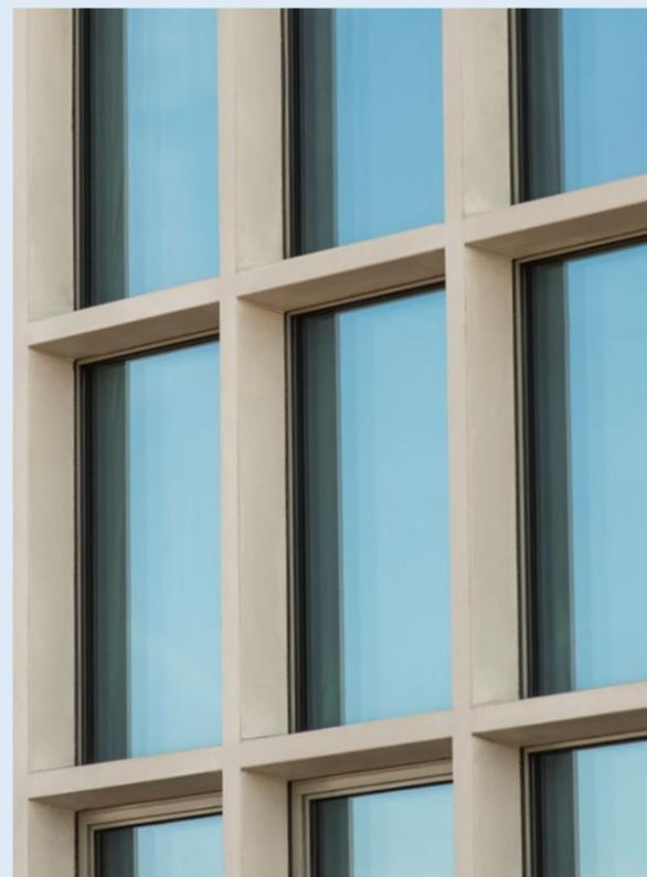
Alte Werte mit neuen Ideen: Aluminiumfenster mit vorgehängten Glasfaserbetonelementen.
