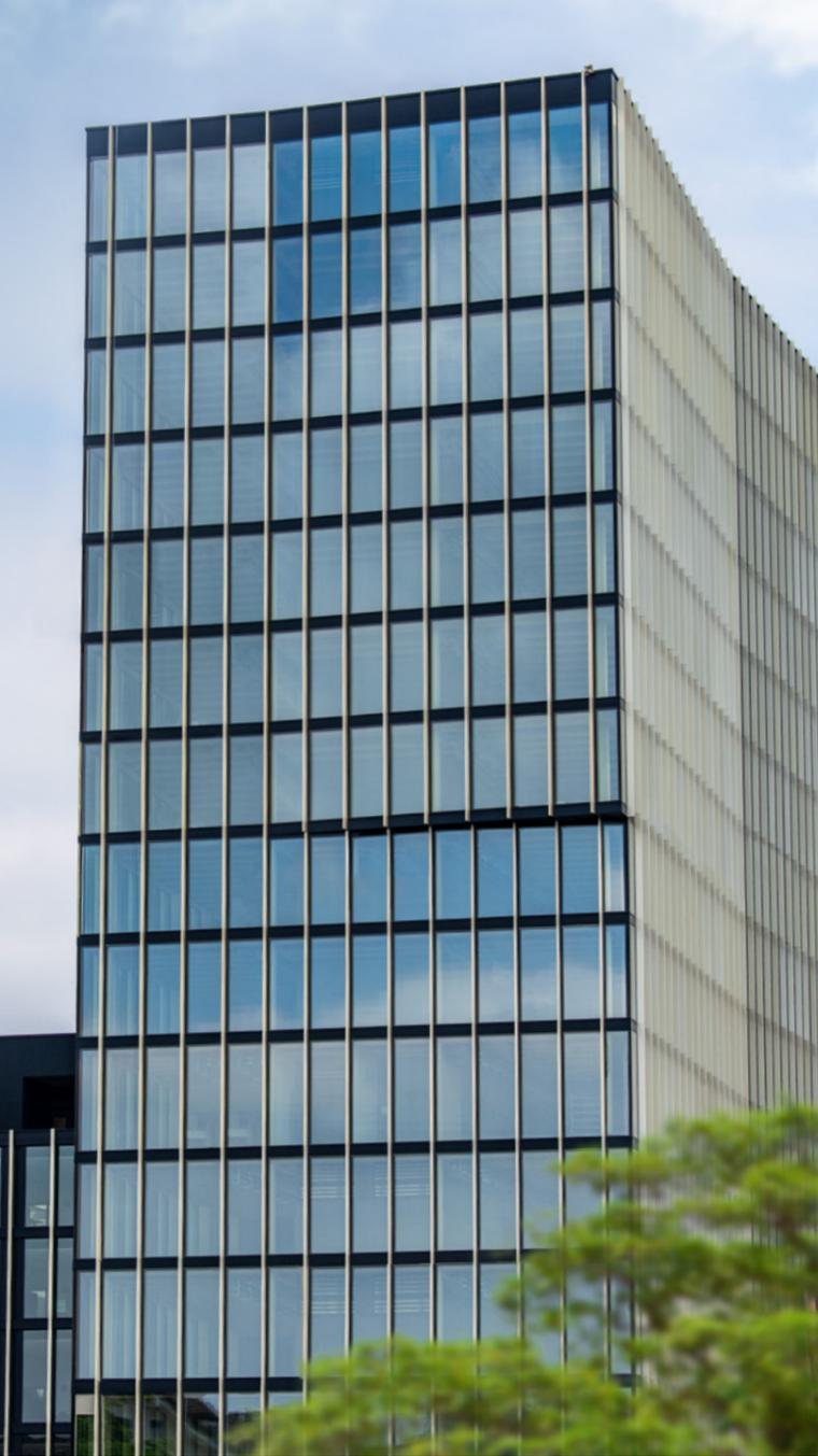
Links: Dämmt Energieverlust, entfacht Begeisterung: der mit 60m höchste Holz-Beton-Hybridbau der Schweiz mit seiner Aepli Air Control®-Fassade.
