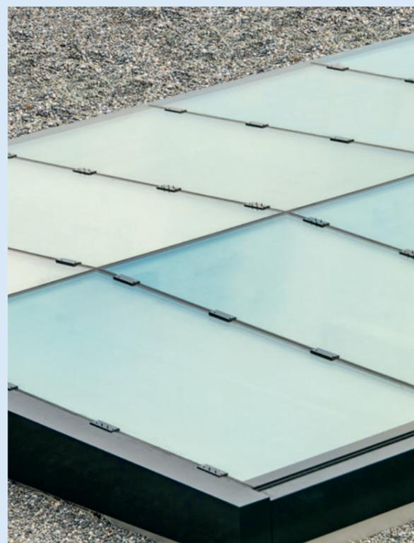
Dachoberlicht Haus B – Die Dachoberlichter von Aepli Metallbau auf dem Dach des Atriums bringen das Tageslicht optimal zur Geltung.
