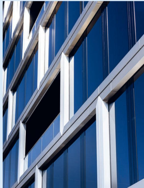
Die unterschiedliche Schliffrichtung der CNS-Bleche erzeugt je nach Tageslicht und Sonneneinstrahlung ein anderes Fassadenbild.
