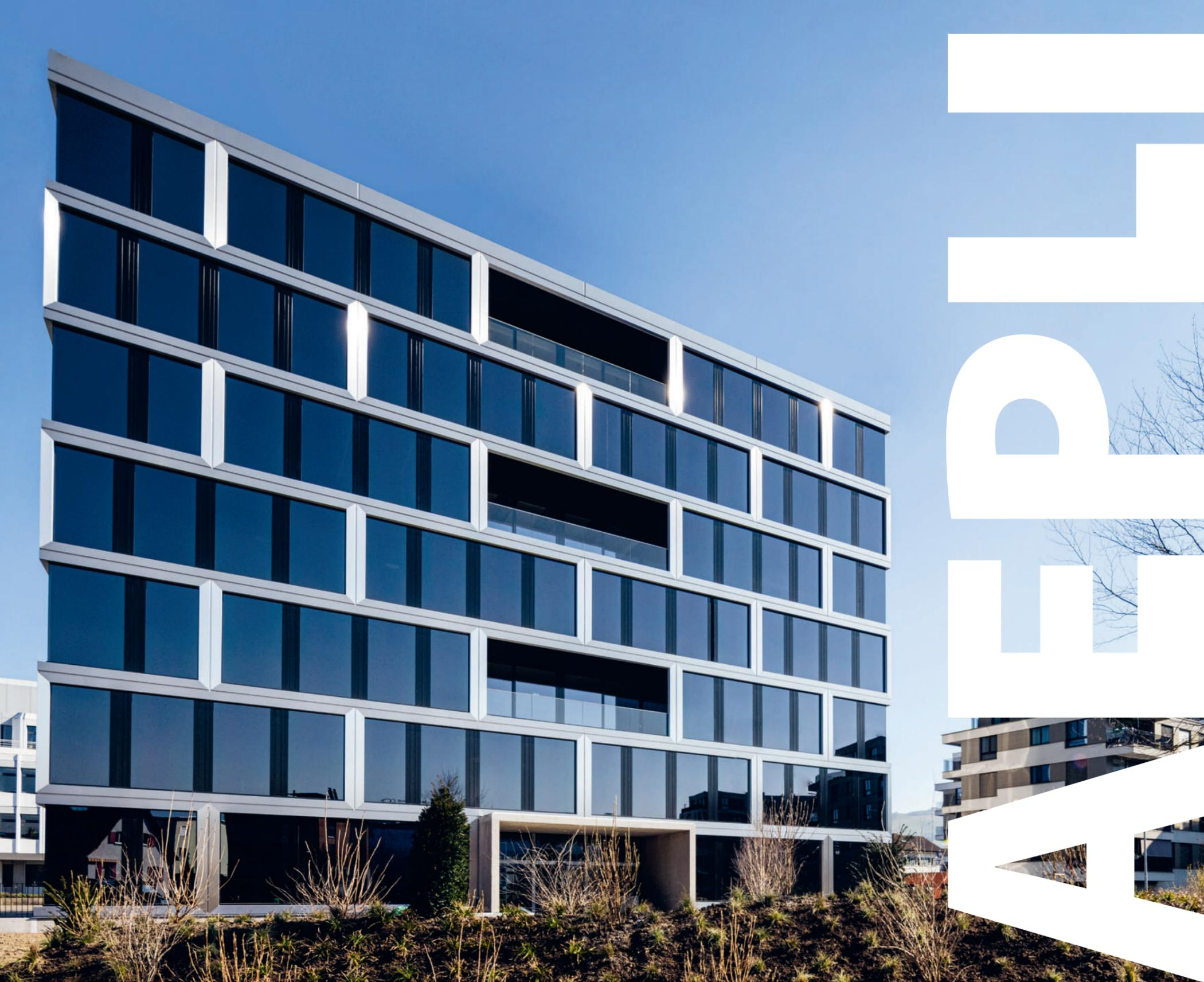
*Die von Aepli Metallbau als Einzelbauteile realisierten CNS-Bleche bilden mit den getönten SageGlass-Fenstern elegante Kontraste.*
