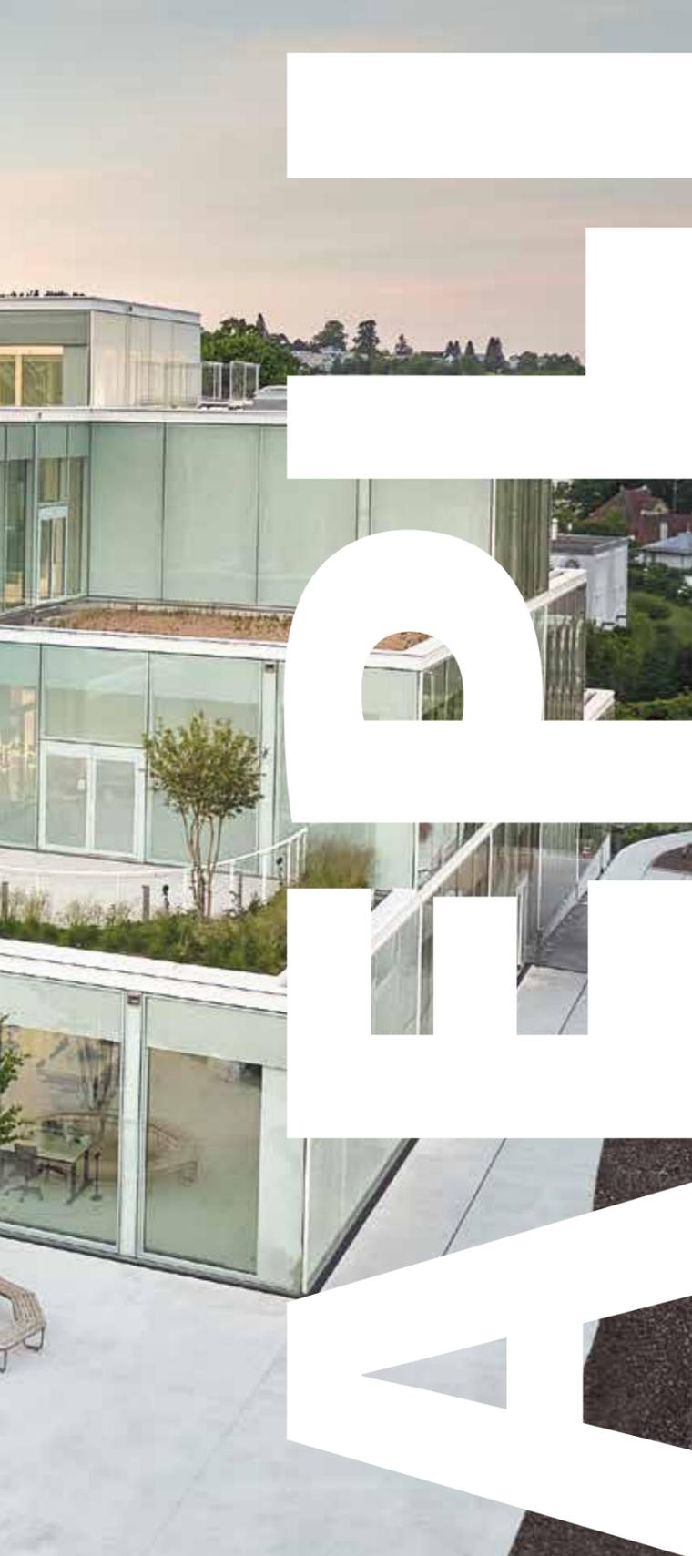
*Transparent, attraktiv und superkomplex zu realisieren: Diese fast schon ätherische Fassade besteht aus 448 Elementen in 304 unterschiedlichen Ausführungen.*
