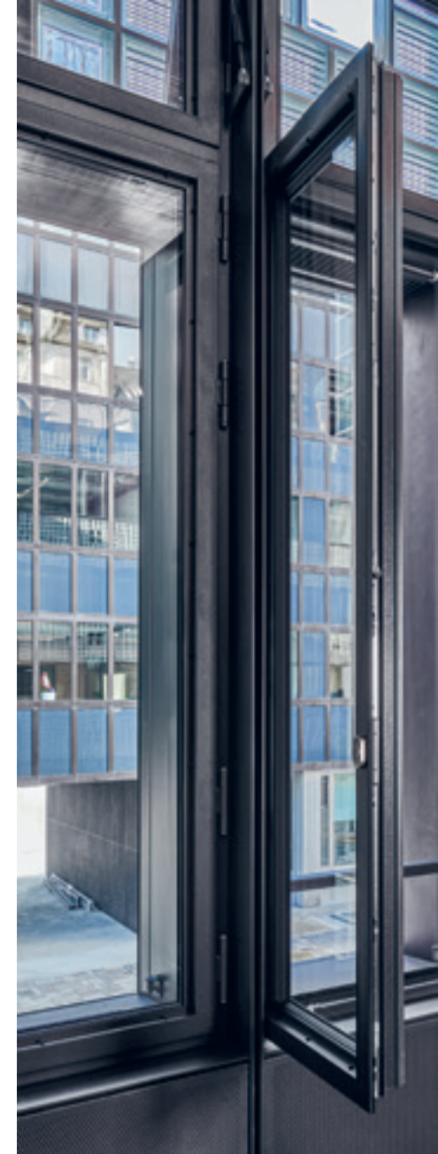
225 kg schwere Fensterflügel mit 2,8 m Ausladung: nur ein Bestandteil der «All-in-one»-Fassade.
