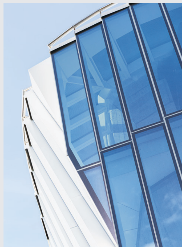
Die einzelnen Elemente wurden vorproduziert mit jeweils 5 Pfosten à 4 Gläser.
