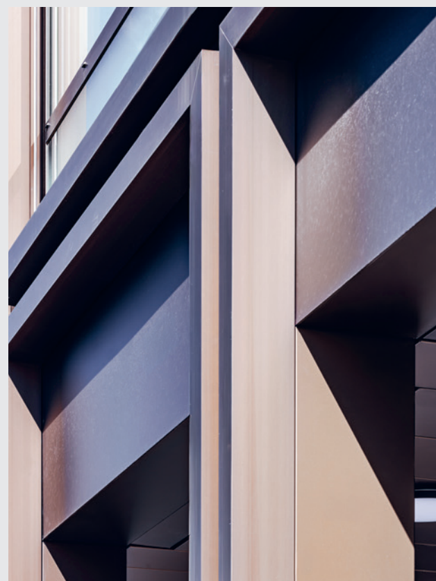
Fassadenelemente, Lisenen sowie Blecheinhäng-elemente strukturieren die Gebäudehülle.
