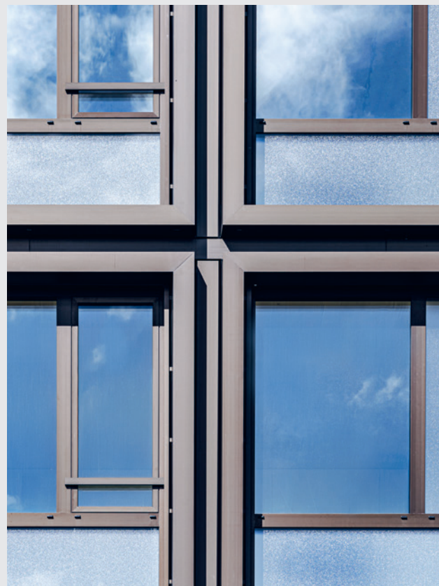
Die Lisenen verleihen der Fassade ein Licht- und Schattenspiel.
