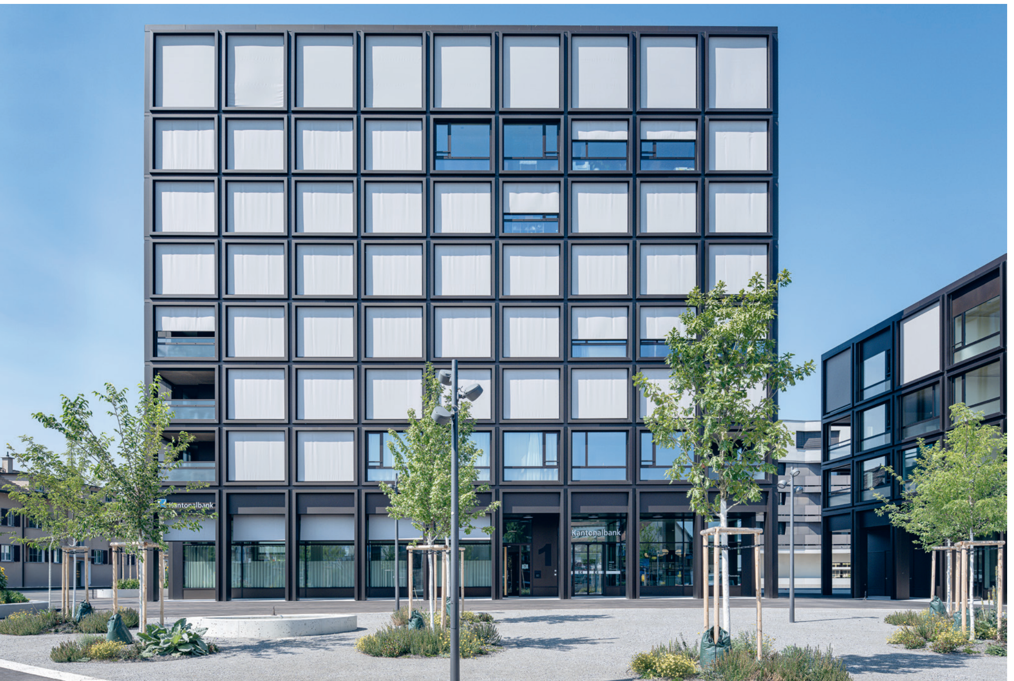
Die Gliederung der Gebäudehülle folgt dem klassischen Dreiklang aus Sockel, Mittelzone und Dachabschluss.
