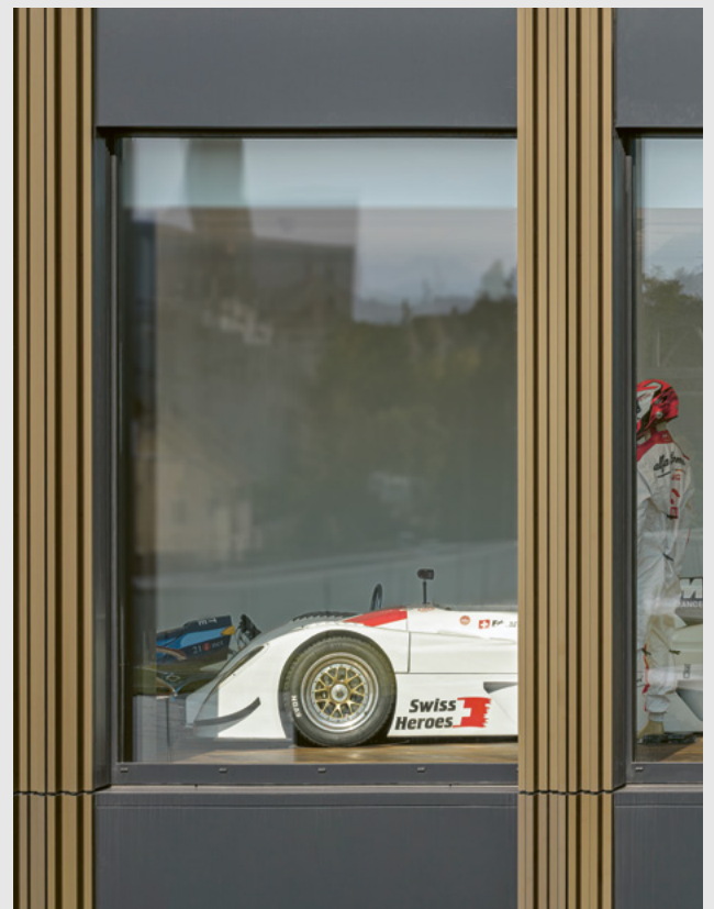
Transparenz und Weite: Die grossflächigen Metall-Glas-Elemente sorgen für lichtdurchflutete Innenräume.
