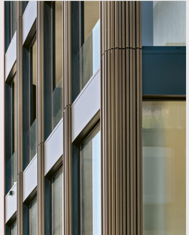
Detailgetreue Präzision: Die Kombination aus pulverbeschichtetem Aluminium und eloxierten Vertikallisenen verleiht der Gebäudehülle ihre charakteristische Struktur.
